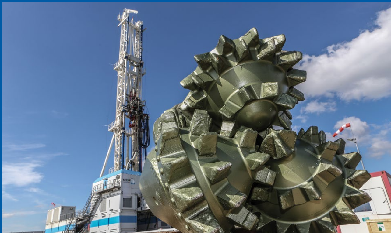
Forage géothermique à Munich
