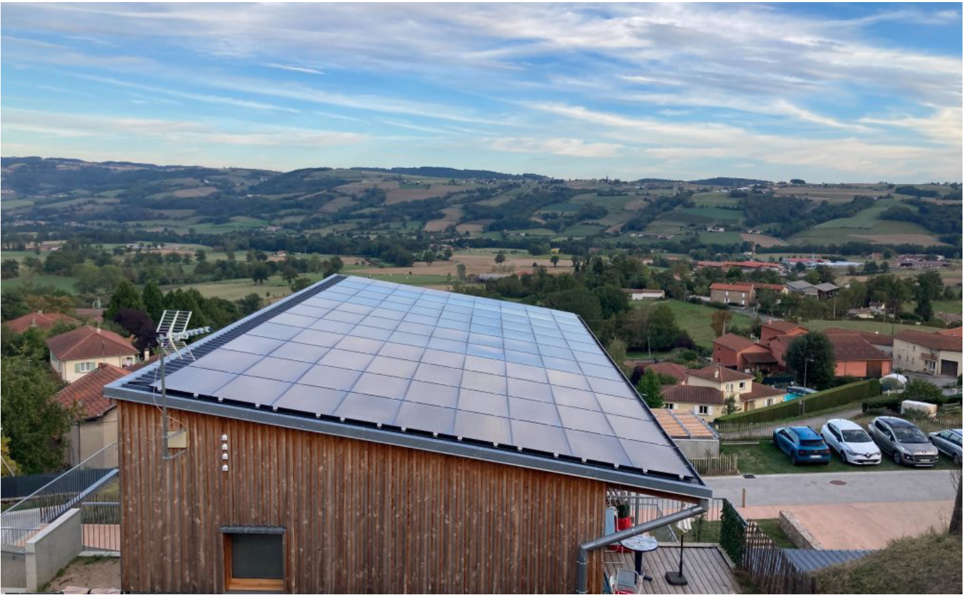
Das Ökoquartier von Meys, Communauté de communes des Monts du Lyonnais | Foto: AFR
